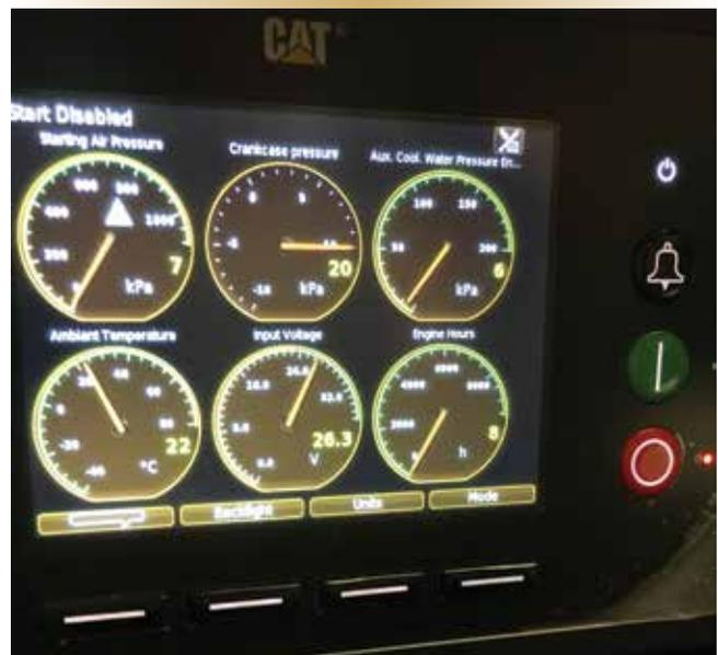
La nouvelle génératrice diesel est dotée d'un système d'extinction d'incendie à la fine pointe de la technologie à l'intérieur de l'enceinte, et d'un panneau de commande moderne de génératrices marines (sur la photo) qui arrêtera automatiquement le moteur si les conditions ne sont pas maintenues.
