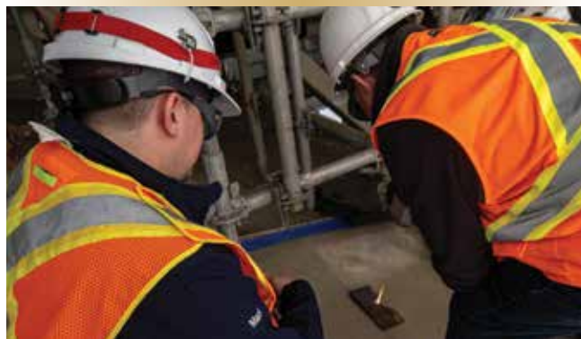
Photo courtoisie de Irving Shipbuilding Inc.
